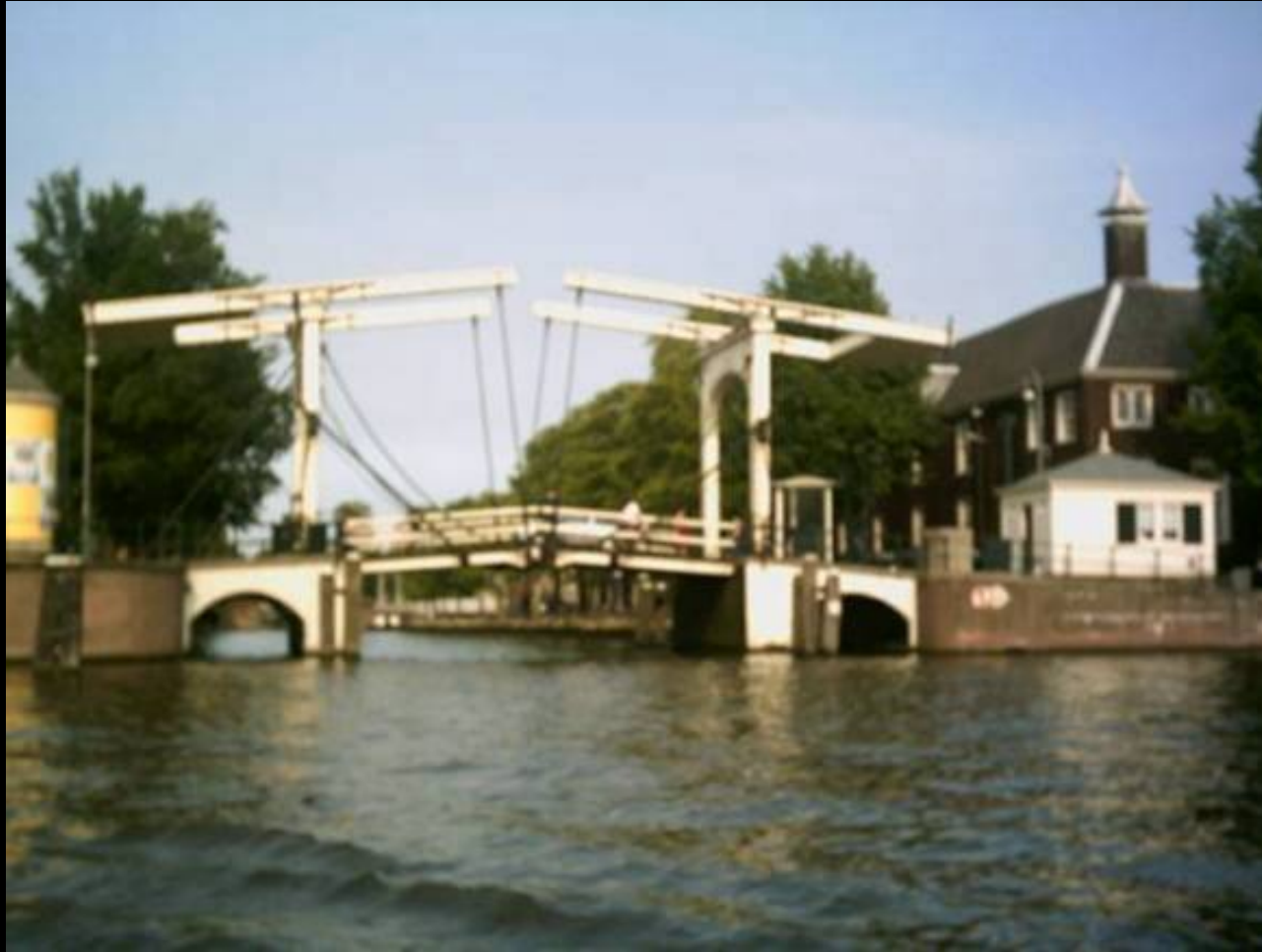
Puente en el canal Amsterdam
